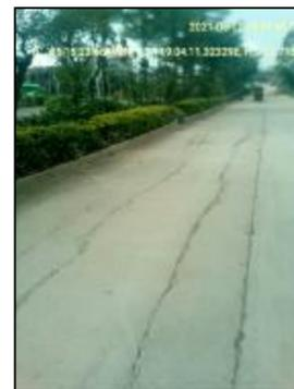
现状水泥路面破损，破除后重新修复
