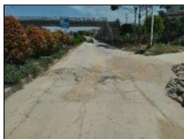
现状水泥路面破损，破除后重新修复
