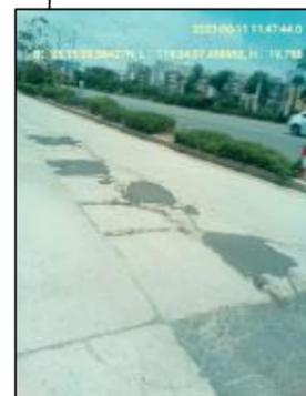
现状水泥路面破损，破除后重新修复
